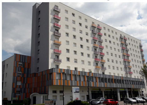
Copropriété de Nantes rénovée BBC © Solécité
