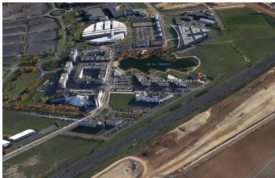
Figure 3 – Vue aérienne du data center de Chasseneuil-du-Poitou
