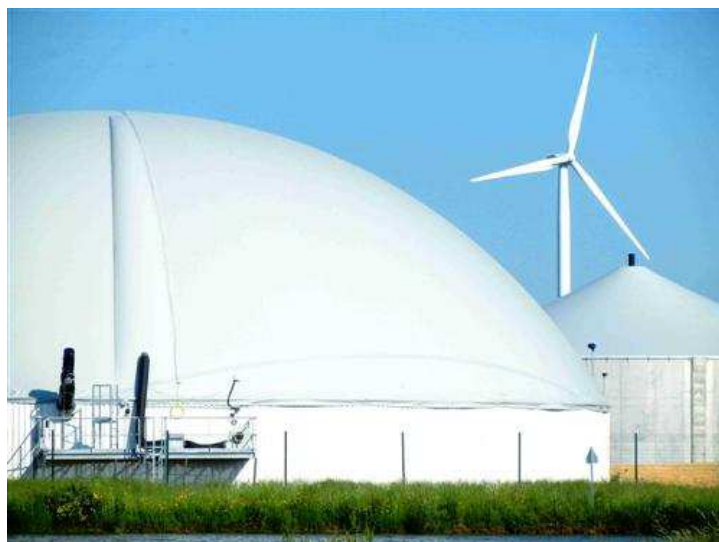
L'unité de méthanisation Valdiz à Issé est la plus importante de Loire-Atlantique
